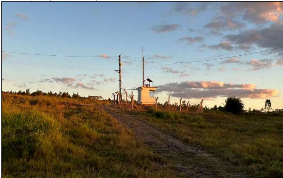
Figura 26 - Sirene principal instalada próximo da casa de comando.
